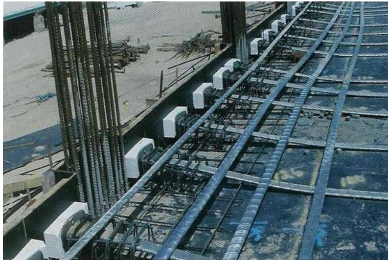
مهارها و غلاف های جاسازی شده در دال قبل از بتن ریزی
